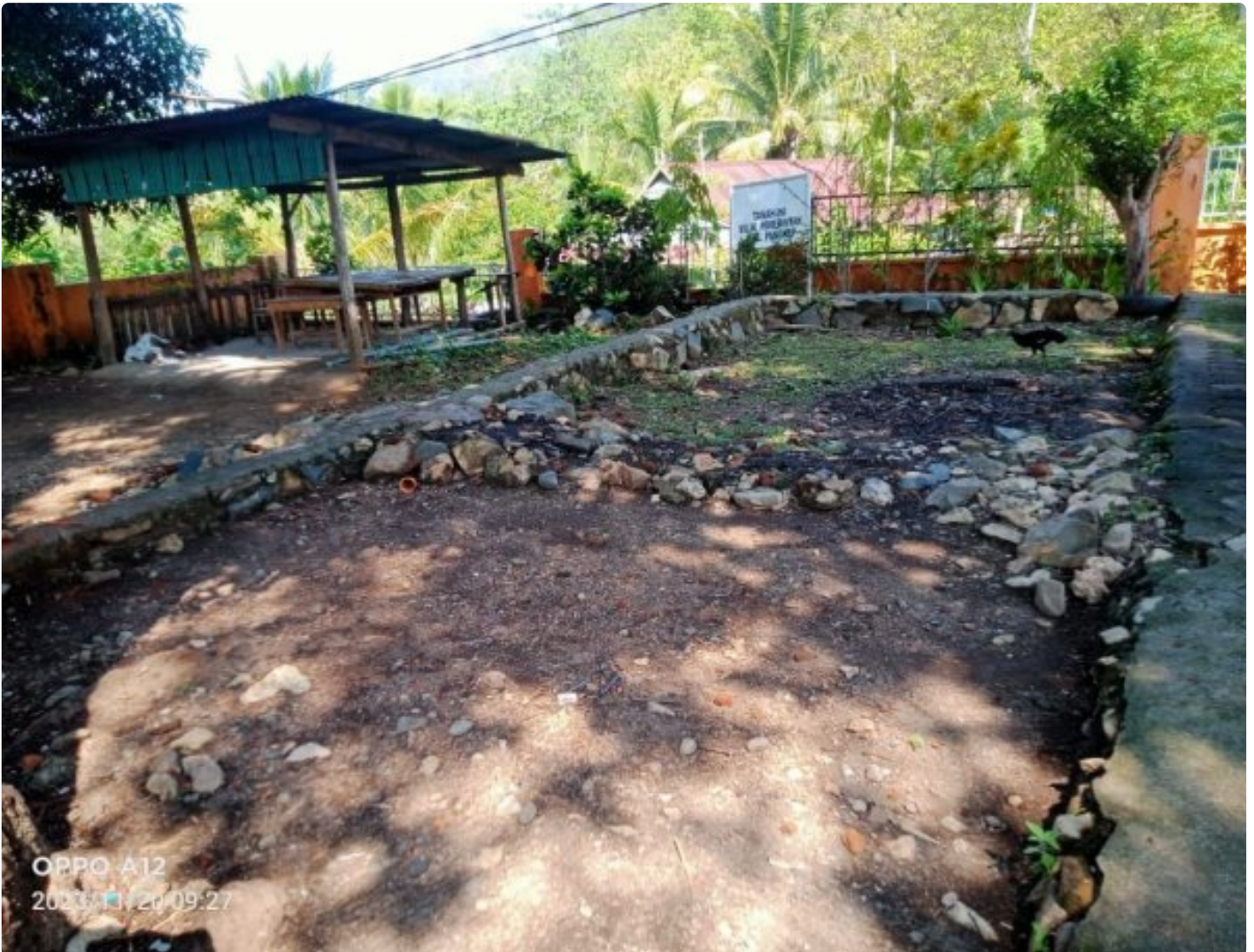
Macet, Baru Pondasi Bangunan Musholla selesai di SDN 19 Batu Napara Balocci
